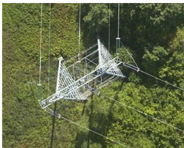
Figura 5: Ejemplo de ortoimagen de una torre de la línea de alta tensión.
